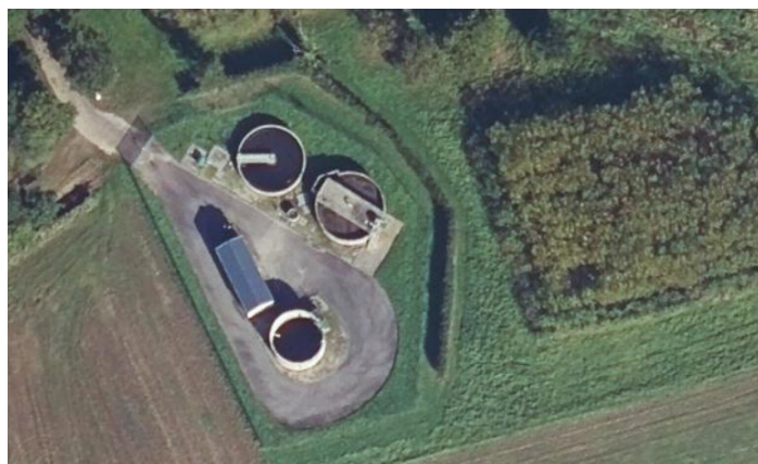
Vue aérienne de la station d'épuration avant la pose des panneaux solaires en 2025
