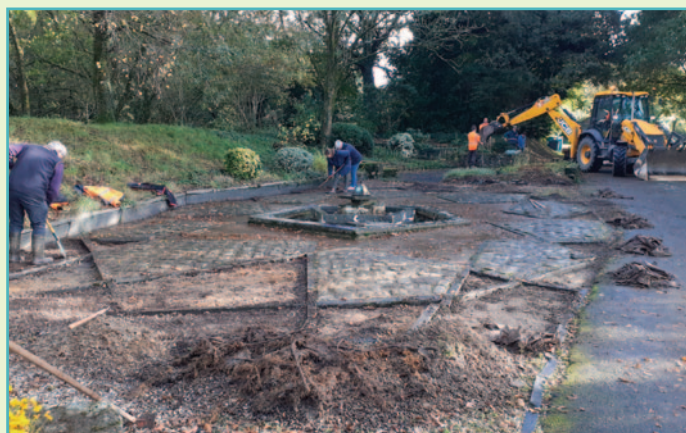
Travaux en cours autour de la Fontaine à l'entrée du plan d'eau avec la participation des services techniques de la commune
