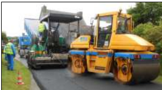
Travaux de voirie à Kerdoupin
