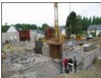
Chantier de la cantine - garderie
