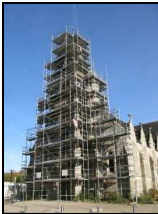
Le clocher de l'Eglise en travaux
