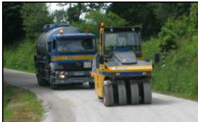
Travaux de voirie réalisés au mois de mai
