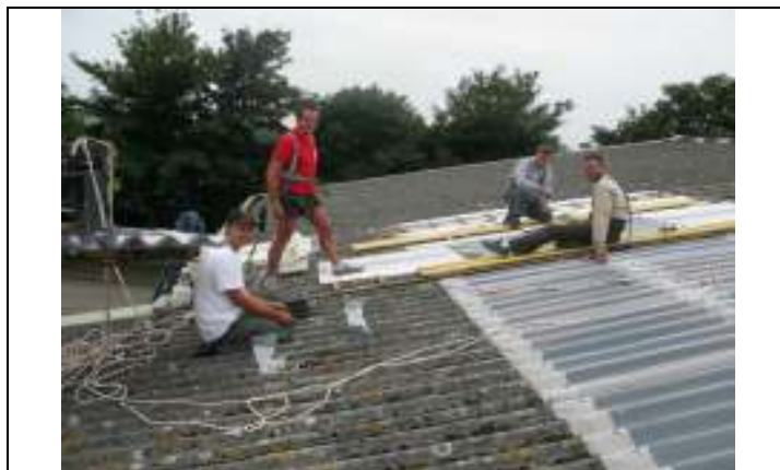
Les couvreurs remplacent les translucides sur la salle des sports
